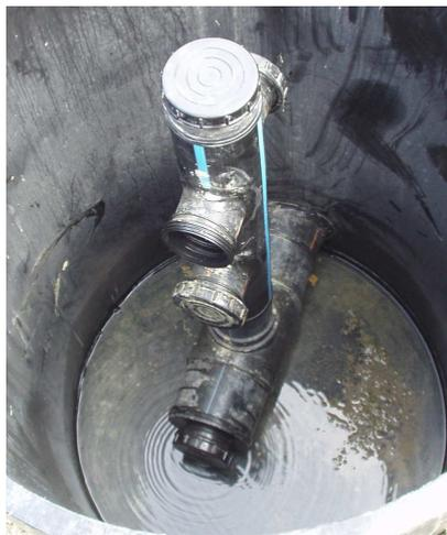
Figura 3.14 – Pozzetto con dispositivo di regolazione.
