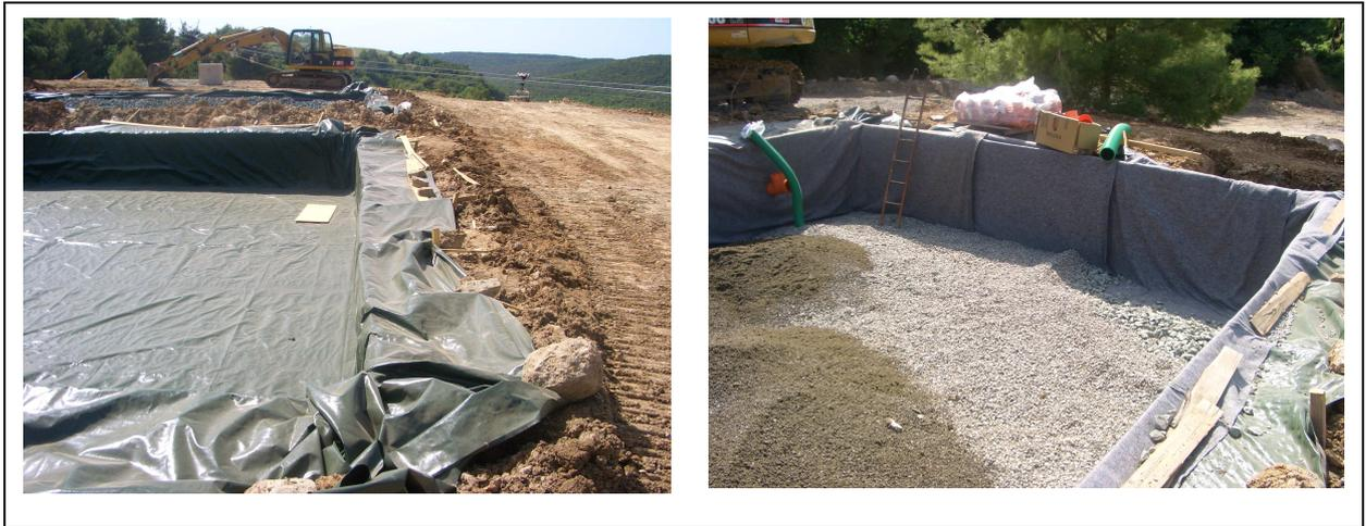
Figura 3.11 –Sistemi di fitodepurazione a flusso sommerso: particolare dell'impermeabilizzazione
