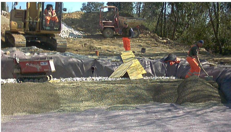
Figura 3.12 – Disposizione del medium di riempimento.
