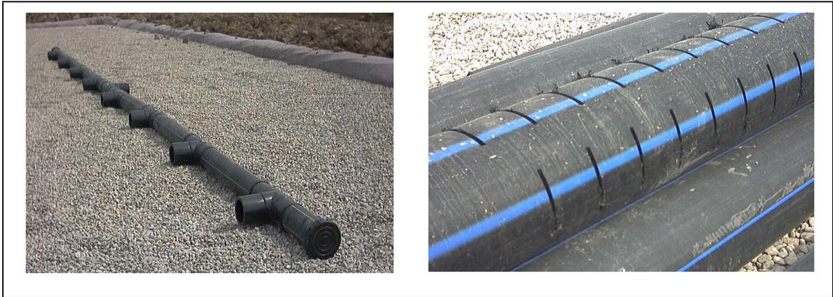
Figura 3.13 – Tubazioni per l'alimentazione dei sistemi HF.
