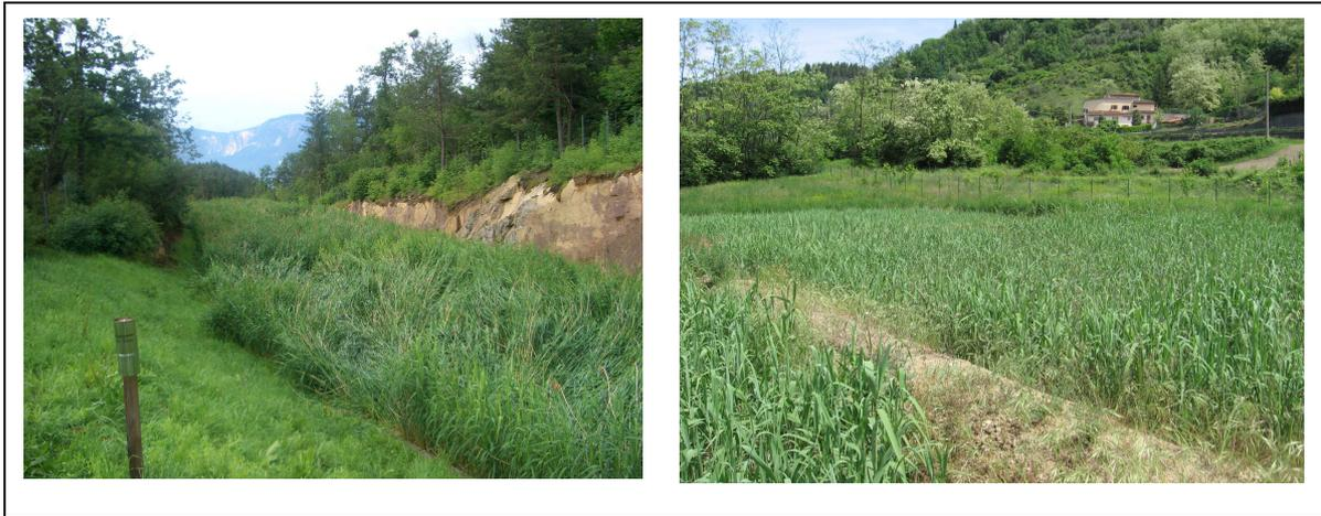
Figura 3.7 – Sistemi a flusso sommerso verticale: sistemi di trattamento a servizio di reflui urbani
