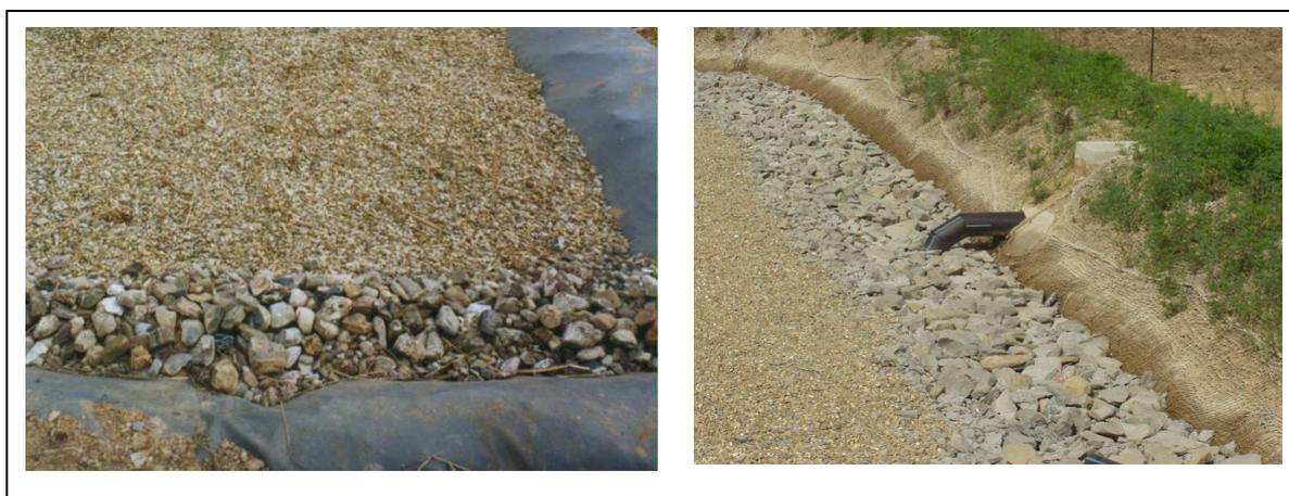
Figura 3.15 –Sistemi di fitodepurazione a flusso orizzontale: particolari dell’area d’ingresso con pietrisco per la corretta distribuzione del refluo
